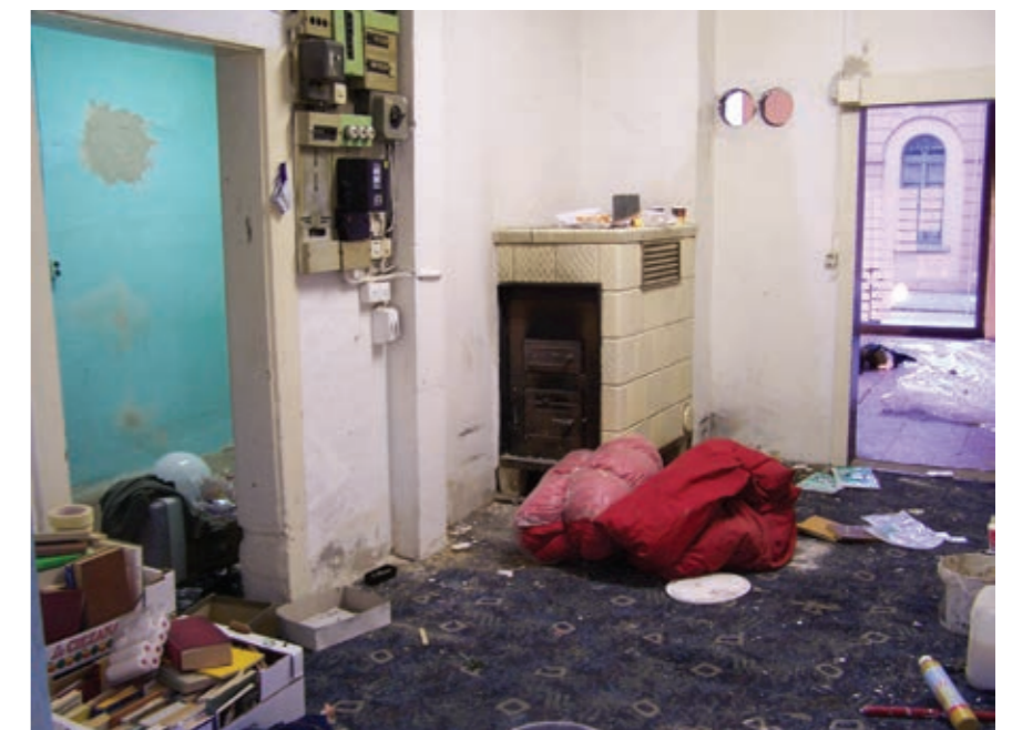
Erstansicht des späteren Salons mit Blick in die spätere Küche. Zur Renovierung gehört in gewisser Weise auch eine Entkernung. Photo: Konstantin Bayer.
